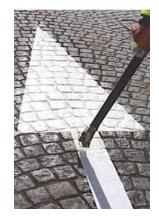
**PREMARK**® con l'applicazione di un primer epossidico esente da solventi, studiato appositamente per l'utilizzo su pavimentazioni in pietra, in lastre prefabbricate e cemento nuovo giunto a completa maturazione.
