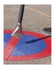
**PREMARK®** è termoplastico e quando viene scaldato si fonde con l'asfalto.
